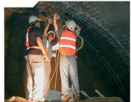
Einbau von Dehnungsgebern in der Kalotte
