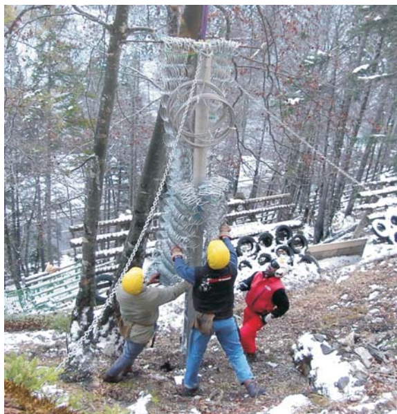
Instalación del sistema de protecciones con ayuda de helicóptero
