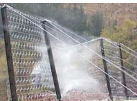
Sistema de protección contra caída de rocas, 600 kJ sin cuerdas de retención.
