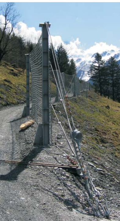
Sistema de protección contra caída de rocas, 600 kJ sin cuerdas de retención.
