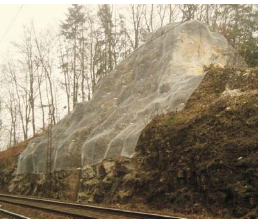
Gran estabilización usando mallas y tejidos de alta resistencia
