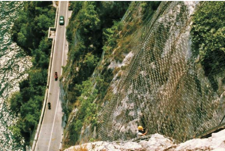
Gran estabilización contra caídas de rocas usando OMEGA-Net
