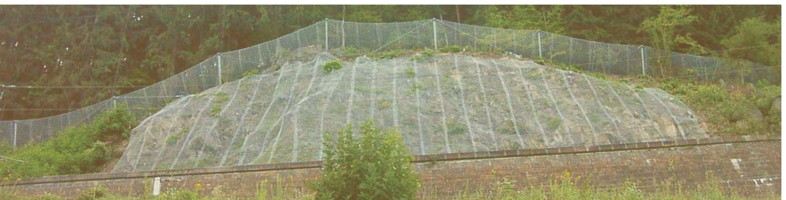
Combinación de estabilización de taludes rocosos con sistema de protección contra caída de rocas
