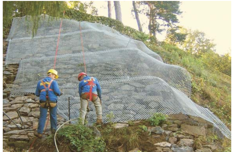
Instalación de malla en talud rocoso
