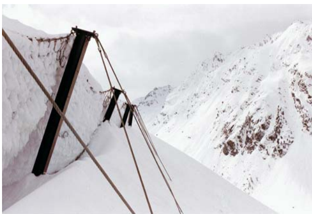
Sistema de protección contra avalanchas DK3,5
