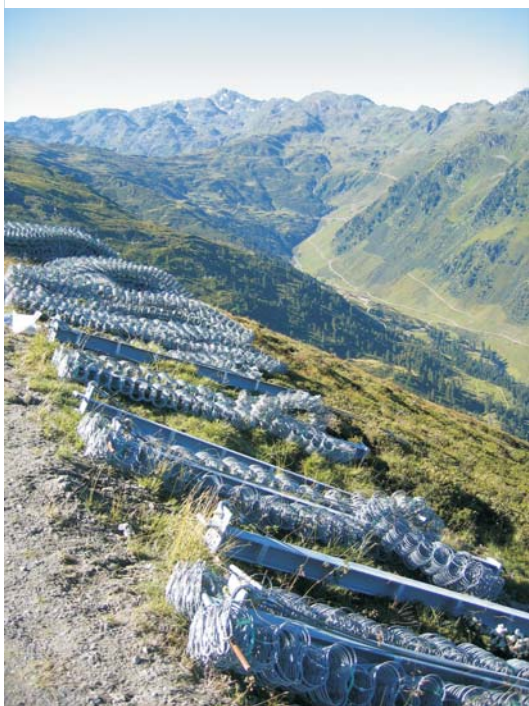
Sistema de protección contra avalanchas preparado para transporte aéreo
